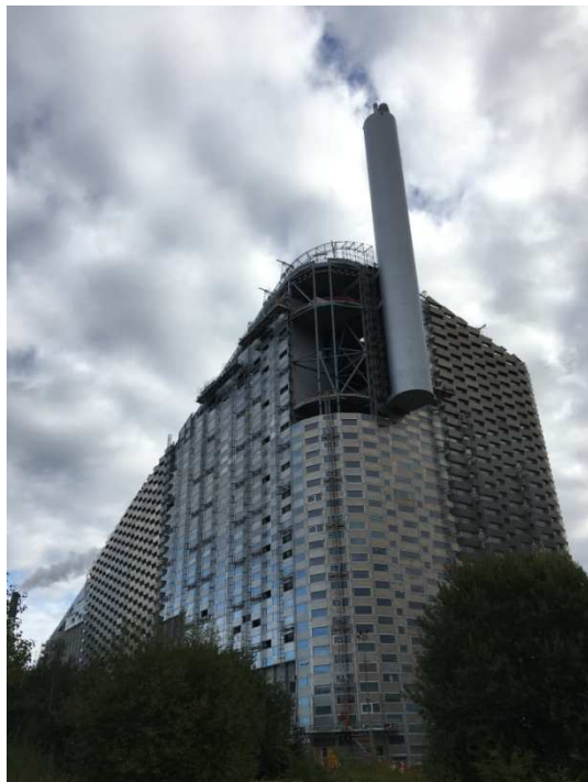
Obr. 5 Věžovitá konstrukce podpůrné dráhy
