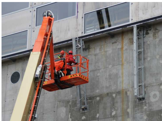
Obr. 1 Montáž příhrad
