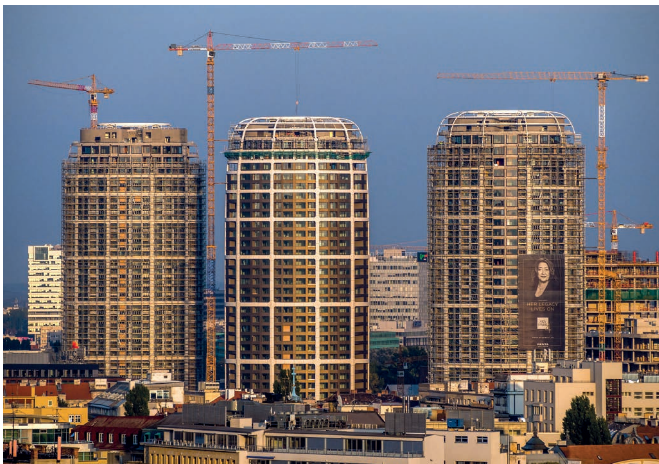
Pohled na tři výškové bytové budovy SKY Park rezidence ve výstavbě
