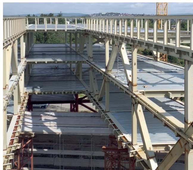
Pohled do konstrukce
