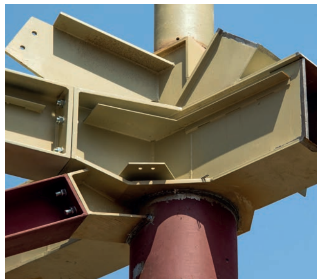
Ocelová konstrukce – styčník
