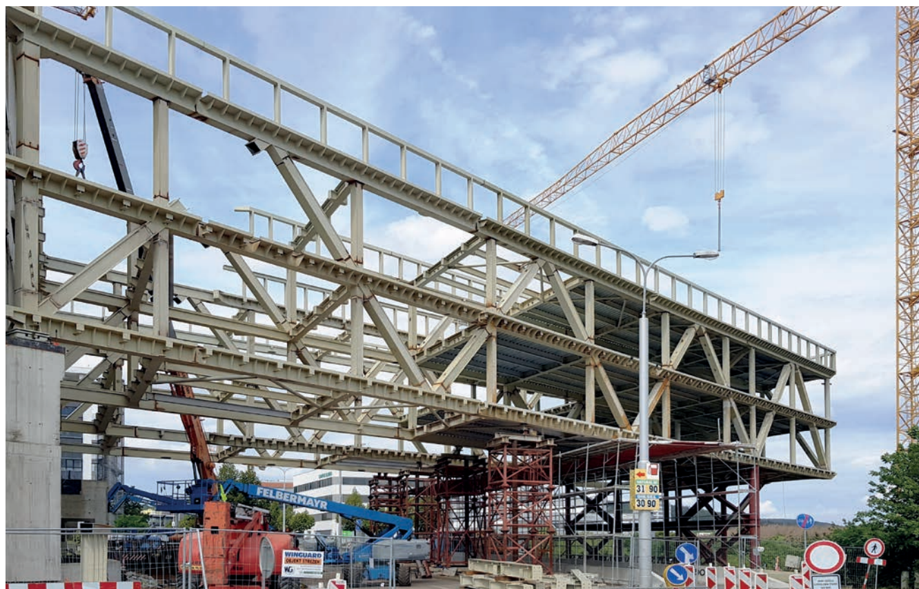
Ocelová konstrukce – montáž
