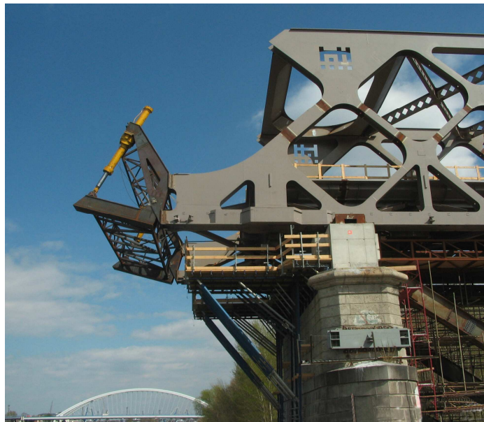
Obr. 7. Klapka po přejezdu pilíře s výsuvným zařízením
