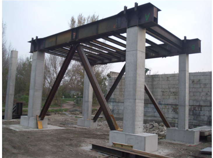
Obr. 5 Příčníky montovny z původních podélníků
