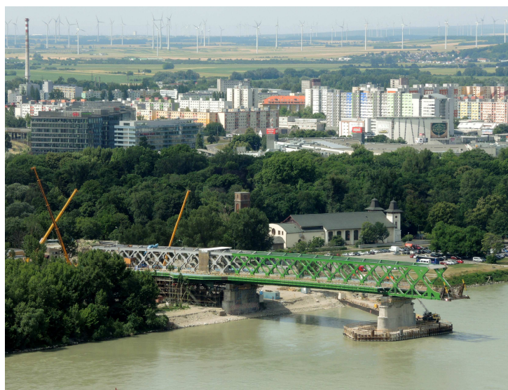
Obr. 4 Pohled na most při výsunu
