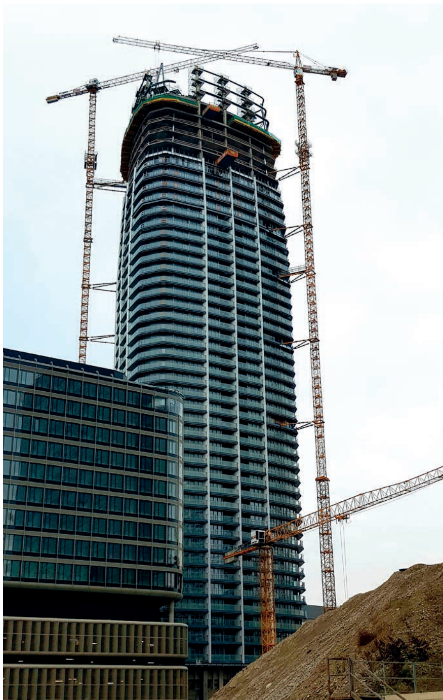
Montáž OK koruny a fasádního pláště.
